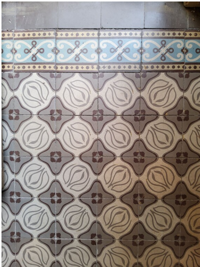
Katholisches Gemeindehaus St. Franziskus Bitterfeld - Fußbodenbelag im Erdgeschoss aus Fliesen der Polko-Werke, Bitterfeld Fotograf/Urheber: NAME FEHLT
