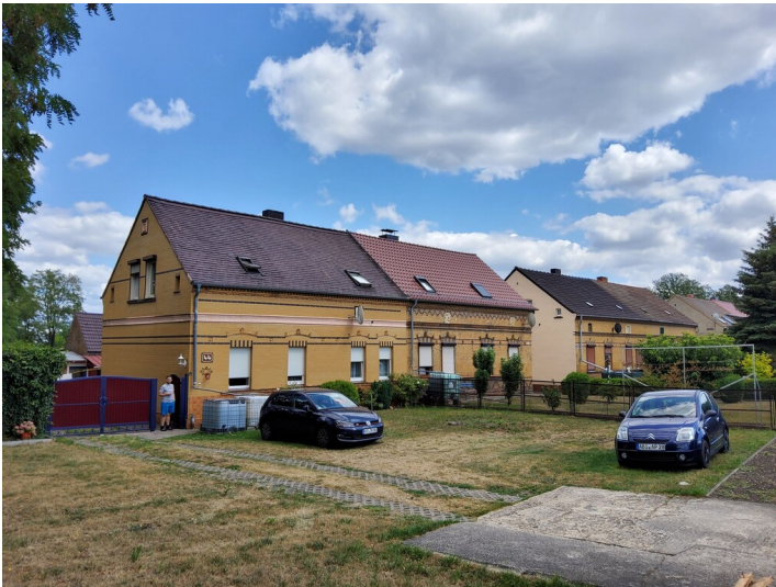
Siedlung Deutsche Grube - Perspektive entlang der Leipziger Straße mit Blick nach Südosten Fotograf/Urheber: NAME FEHLT
