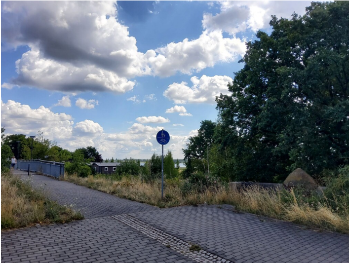
Alte Muldebrücke - Blick zum See Fotograf/Urheber: NAME FEHLT
