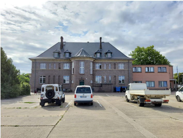
Verwaltungsgebäude des Steinzeugwerks - straßenabgewandte Nordwestfassade Fotograf/Urheber: NAME FEHLT
