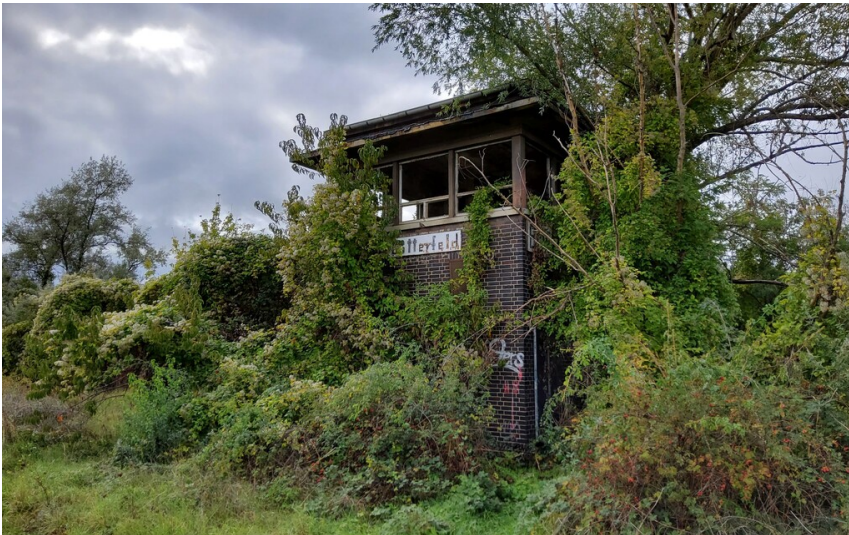
Stellwerk der Strecke Bitterfeld-Stumsdorf - streckenseitige Ansicht Fotograf/Urheber: NAME FEHLT
