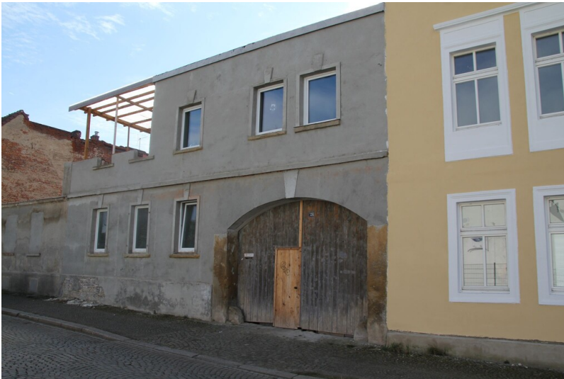
Kohlenhandlung Kutzschbauch - Gesamtansicht strassenseitig Fotograf/Urheber: NAME FEHLT
