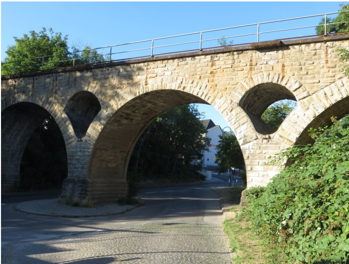
Eisenbahnbrücke Strecke Naumburg - Zeitz - Straßenseitige Gesamtansicht Fotograf/Urheber: NAME FEHLT
