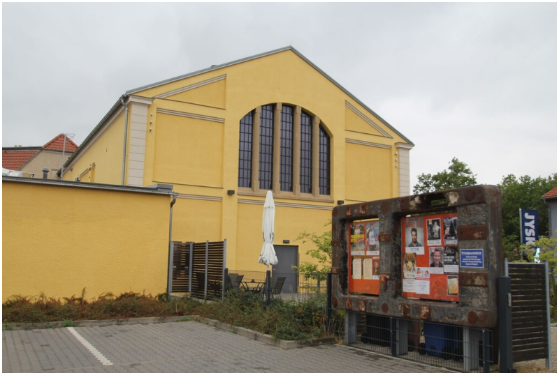
Elektrizitätswerk Naumburg - Turbinenhaus hofseitig Fotograf/Urheber: NAME FEHLT
