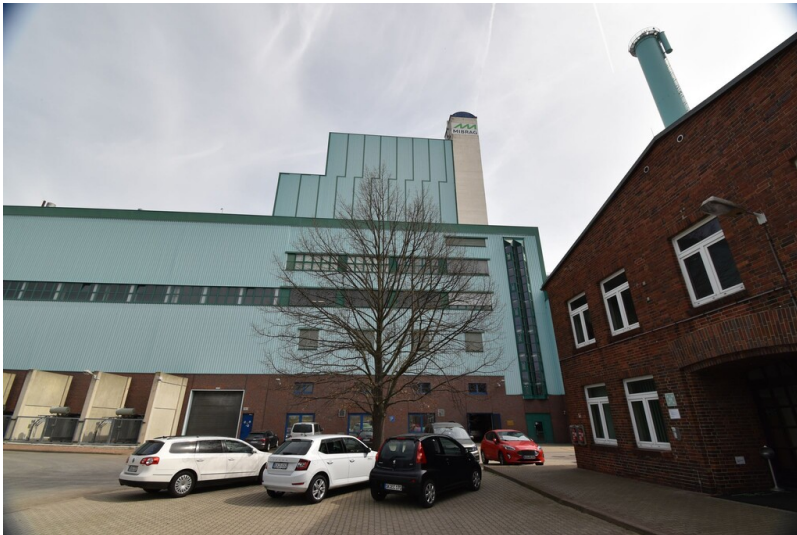
Kraftwerk Wühlitz (MIBRAG) - neues Kraftwerk mit Gebäude-Altbestand (rechts) Fotograf/Urheber: NAME FEHLT
