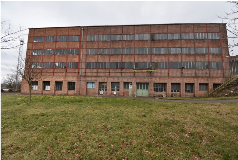
elektrische Energieversorgung Deuben - Westfassade der 110-kV-Anlage Fotograf/Urheber: NAME FEHLT
