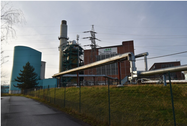
Kraftwerk Deuben - Kraftwerk mit Turbinenhaus, REA und Schornstein mit Blick nach Süden Fotograf/Urheber: NAME FEHLT
