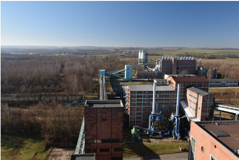
Gesamtstandort Veredlungskomplex Deuben - Blick vom Schornstein des Kraftwerks nach Süden über das Gelände des Industriekomplexes Deuben Fotograf/Urheber: NAME FEHLT
