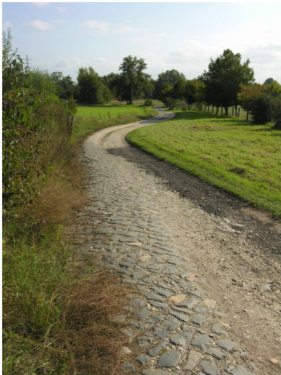
Werkstraße zur Schwelerei Alexandrine (um 1900) - gepflasterte Werksstraße von der Schwelerei Alexandrine; Blick S Fotograf/Urheber: NAME FEHLT
