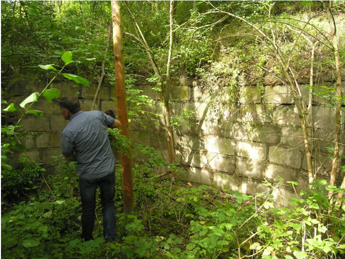
Kraftwerk Theißen (1926-1971) - Fundamentreste der Schornsteine aus Betonsteinen Fotograf/Urheber: NAME FEHLT
