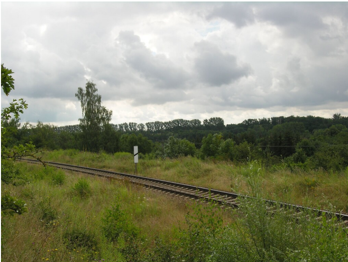
Damm der Eisenbahntrecke Zeitz-Weißenfels (1859) - Bahndamm, Blick SE Fotograf/Urheber: NAME FEHLT
