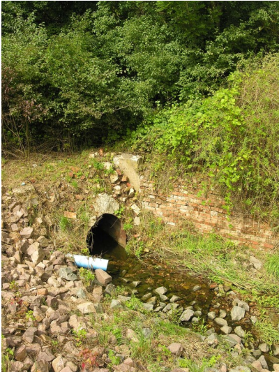
Kanalisation des Maibaches - nach Sanierung, zum Teil wieder geöffneter Bachlauf Fotograf/Urheber: NAME FEHLT
