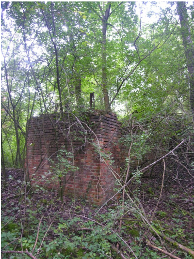
Bahndamm mit sogenannter "Tonbrücke" (1936-1960) - Pfeilern und Stützmauern der "Tonbrücke"; Bloick S Fotograf/Urheber: NAME FEHLT
