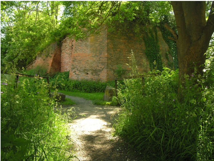
Damm eines Anschlussgleises zu den Fabriken Grube Emma und Grube Kurt (nach 1871-1960) - Stützmauer für die Überbrückung des Maibaches, Blick SW Fotograf/Urheber: NAME FEHLT
