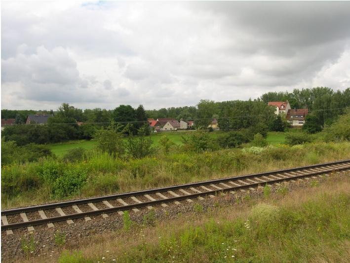
Vermutliches Bruchfeld der Grube Virginia (vor 1895) - Bruchfeld der Grube Virginia, Wiesen jenseits des Bahndammes; Blick Richtung SW nach Luckenau Fotograf/Urheber: NAME FEHLT
