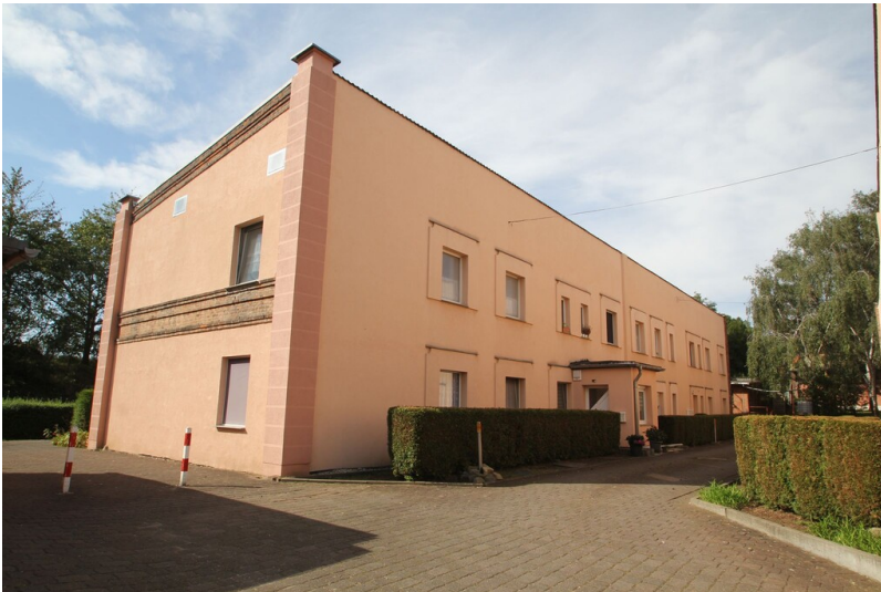
Schacht, Tagesanlage und Nasspresse der Grube Johannes - Gebäudeansicht Fotograf/Urheber: NAME FEHLT
