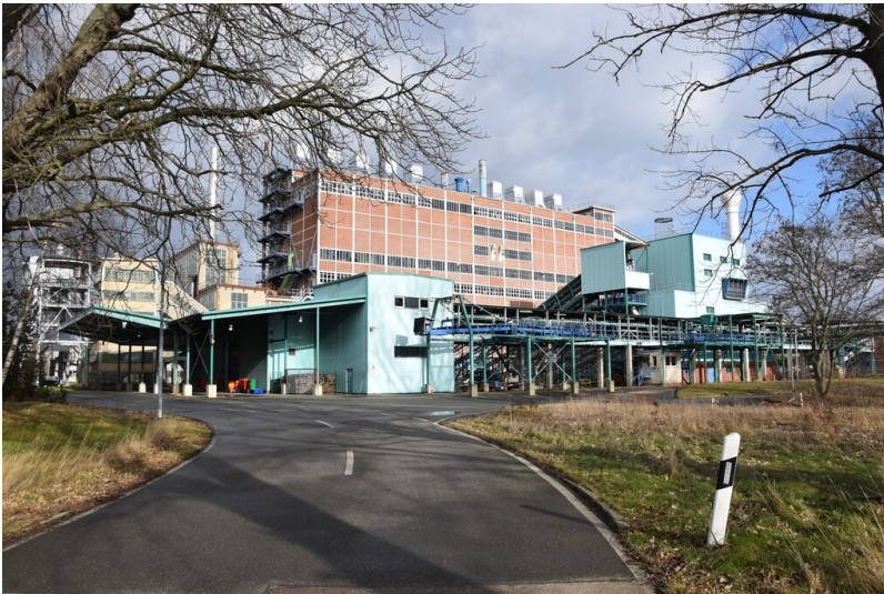
Brikett- und Staubfabrik - Brikettfabrik aus südlicher Richtung Fotograf/Urheber: NAME FEHLT
