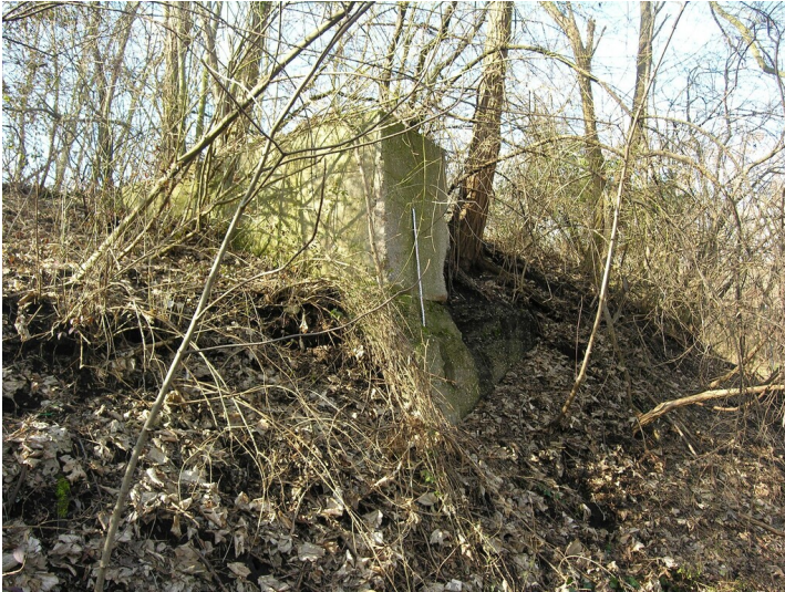
Fundamente einer Rohrleitungstrasse - Fundamente einer Rohrleitungstrasse Fotograf/Urheber: NAME FEHLT
