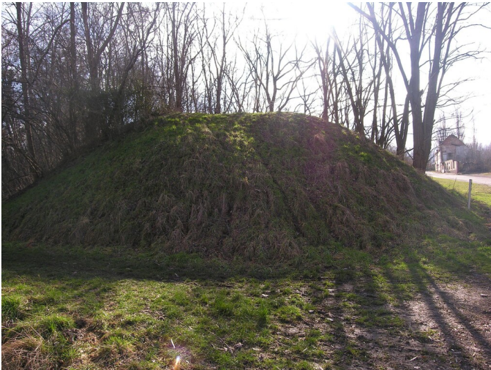
Bahnanschluss der Grube von Voß - Relikt des Bahndammes, Bereich ehemaliger Überbrückung der Karl-Liebnecht-Straße; Brückenwangen abgerissen; Blick E Fotograf/Urheber: NAME FEHLT
