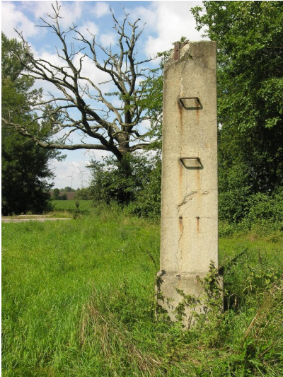
Betnumhüllter Gittermast - Relikt eines betnumhüllten Mastes Fotograf/Urheber: NAME FEHLT
