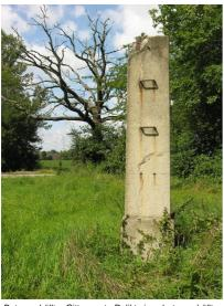
Betonumhüllter Gittermast - Relikt eines betonumhüllten Mastes Fotograf/Urheber: NAME FEHLT
