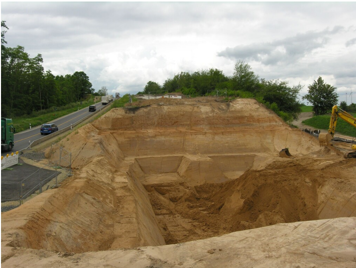
Damm der Chaussee Zeitz-Weißenfels - Damm der Chaussee Zeitz-Weißenfels auf Sicherheitspfeiler; Blick NW Fotograf/Urheber: NAME FEHLT
