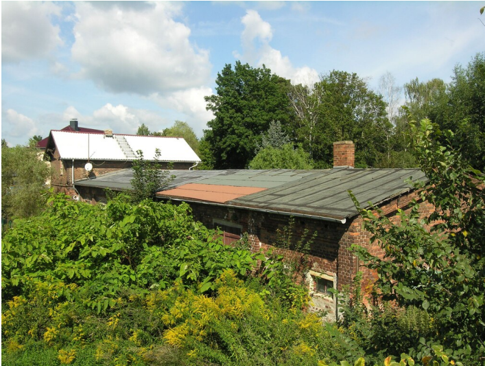
Werkstatt der Grube Hedwig - das Werkstattgebäude der Grube Hedwig heute Fotograf/Urheber: NAME FEHLT
