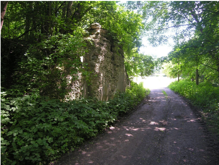
Kohlebahn von der Grube Waldau I zum Bahnhof Waldau - Damm und Fundamente für ehemalige Überbrückung des Weges zum Bahnhof Fotograf/Urheber: NAME FEHLT
