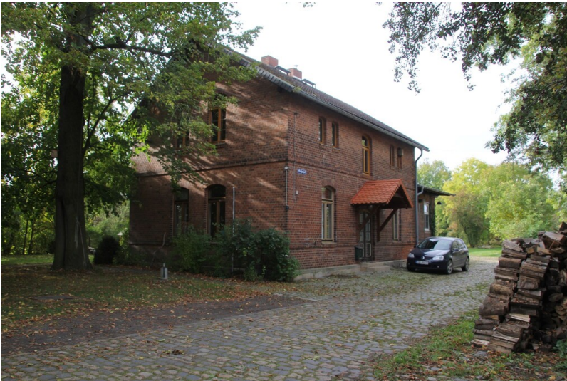
Bahnhof Cauerwitz - Gesamtansicht Bahnhofgebäude Fotograf/Urheber: NAME FEHLT
