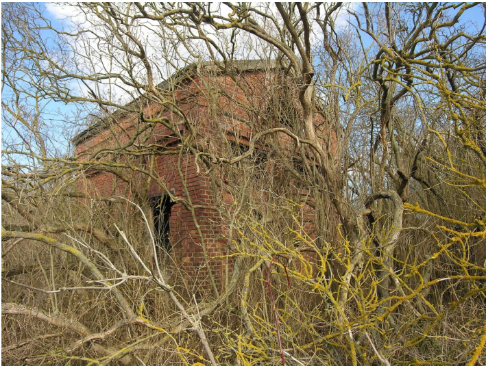
Trafohaus der Grube Neue Sorge - Trafohaus der Grube Neue Sorge (um 1915-1937) Fotograf/Urheber: NAME FEHLT
