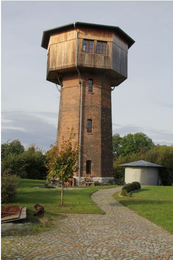
Wasserturm bei Cauerwitz - Wasserturm Bahnanlage Cauerwitz an der Bahnlinie Zeitz - Camburg Fotograf/Urheber: NAME FEHLT
