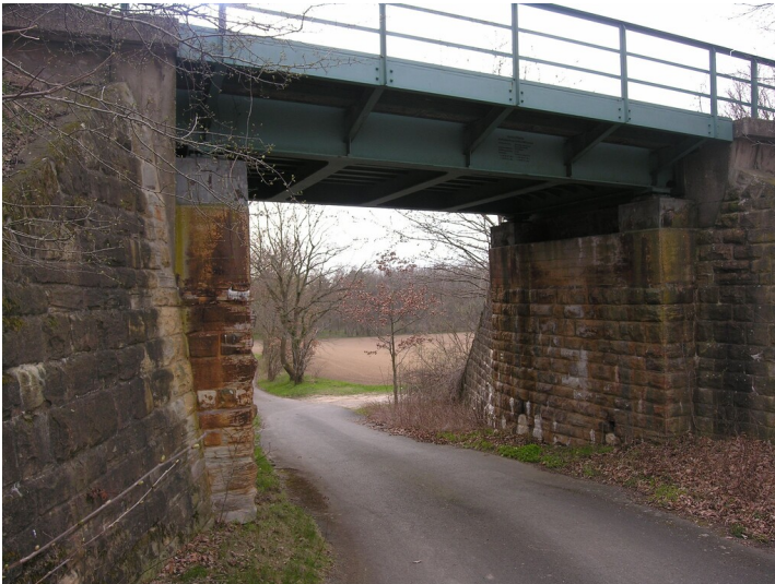
Eisenbahndamm mit Brücke - Bahnunterführung, Weg nach Scheiplitz Fotograf/Urheber: NAME FEHLT
