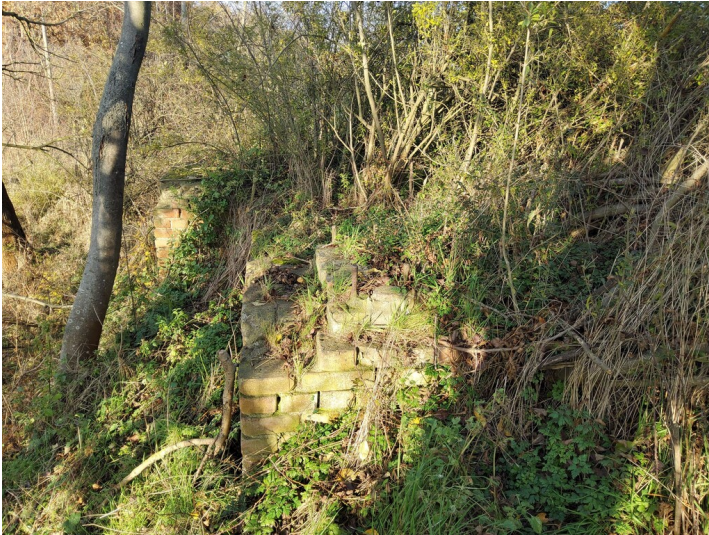
Grube Sössen - Nordwestliche Ecke mit Backsteinwand Fotograf/Urheber: NAME FEHLT
