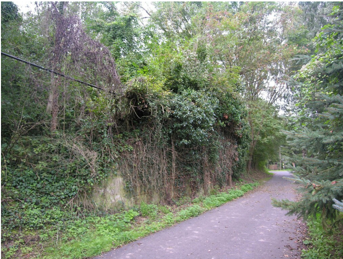
Eisenbahndamm über die Thierbach-Aue - Stützmauer einer Brücke, an der Aschehalde; Blick W Fotograf/Urheber: NAME FEHLT
