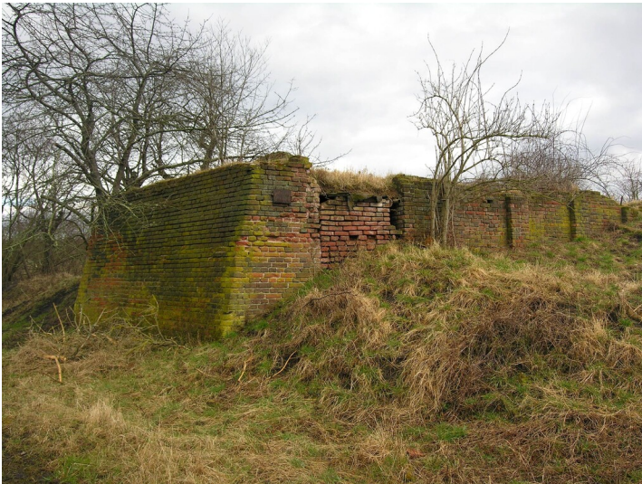
Seilbahnüberführung bei Querung der Landstraße Theißen-Grana - Fundamente und Stützmauern mit Ziegelmauerwerk Fotograf/Urheber: NAME FEHLT
