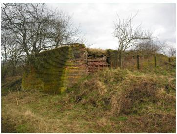
Seilbahnüberführung bei Querung der Landstraße Theißen-Grana - Fundamente und Stützmauern mit Ziegelmauerwerk Fotograf/Urheber: NAME FEHLT
