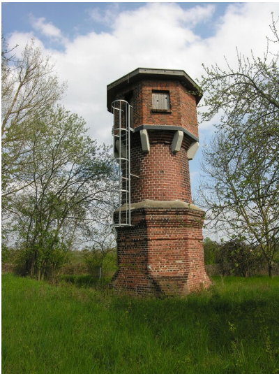
Wasserturm der Grube Neue Sorge - der Wasserturm; Blick Nord Fotograf/Urheber: NAME FEHLT
