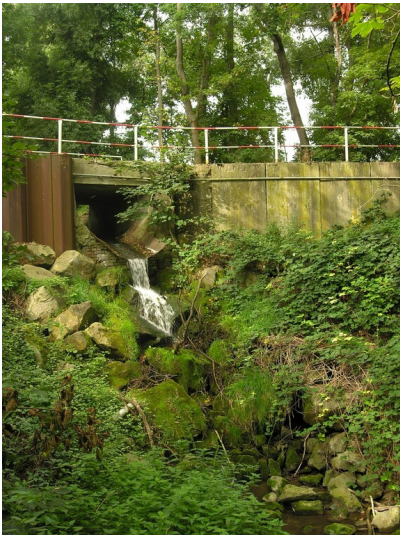
Umleitung des Gladitzer Baches für die Grube Groitzschen - Bachdurchlauf mit Abfluss zum See Kretzschau Fotograf/Urheber: NAME FEHLT
