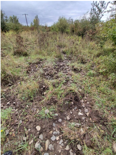
Damm einer Kohle- und Abraumbahn - Schotter auf Kamm des Dammes Fotograf/Urheber: NAME FEHLT
