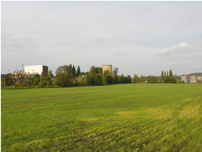
Mineralöl- und Paraffinfabrik Webau Werk II - das Fabrikgelände aus südwestlicher Richtung gesehen Fotograf/Urheber: NAME FEHLT
