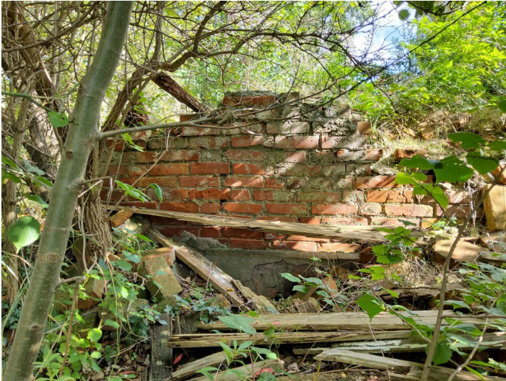
Revierhaus der Grube 247 - Grundmauern Fotograf/Urheber: NAME FEHLT
