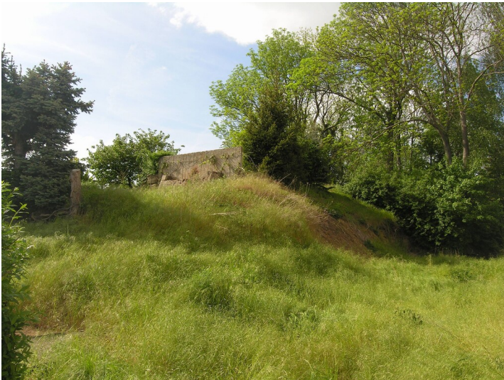
Kohlebahn von Profen-Bösau zur Fabrik Wähilitz - Bahndamm nördlich der ehemaligen Straßenüberbrückung; Blick NW Fotograf/Urheber: NAME FEHLT
