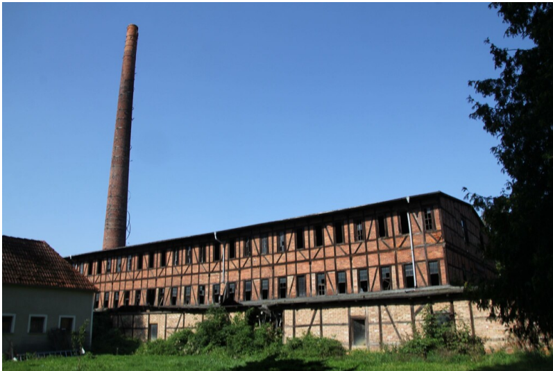
Ziegelei Hohenmölsen - Gesamtansicht Ziegeleibau mit Schornstein Fotograf/Urheber: NAME FEHLT
