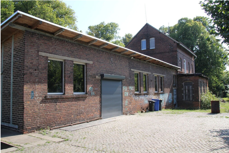
Bahnhof Hohenmölsen - Bahnhof Hohenmölsen Gepäckabfertigung Gleisseite Fotograf/Urheber: NAME FEHLT
