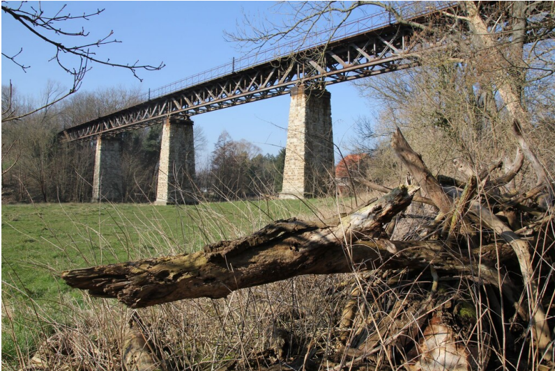
Eisenbahnviadukt über das Rippachtal - Rippach Eisenbahnviadukt Gesamtansicht Fotograf/Urheber: NAME FEHLT
