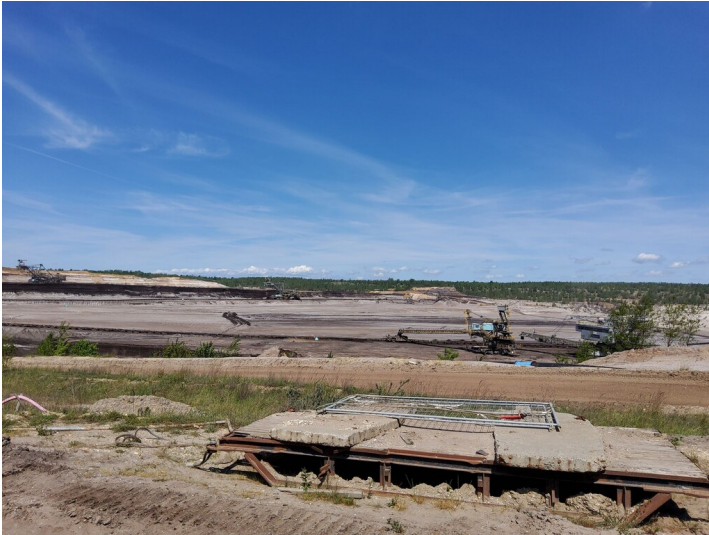
Bagger 1511 und 1580 - Blick auf Bagger 1511 und baugleichen Bagger 1580 Fotograf/Urheber: NAME FEHLT
