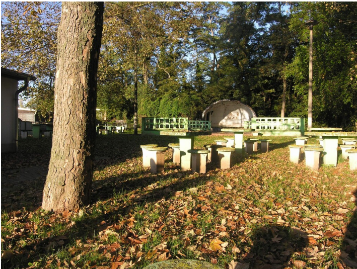
Extensiv genutztes Gelände der Fabrik Alt-Gerstewitz - Ehemaliges Werksgelände, in den 1970er Jahren Festplatz mit Kegelbahn und Konzertmuschel; Blick West, zur Aschehalde. Fotograf/Urheber: NAME FEHLT
