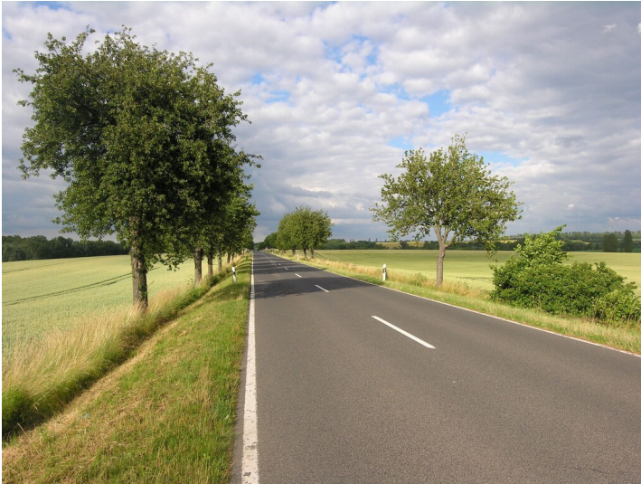
Bruchfeld der Grube Gustav - Straße nach Taucha, auf einem Sicherheitsfeiler; beiderseits deutliche Absenkungen über den Bruchfeldern der Grube Gustav; Blick Ost Fotograf/Urheber: NAME FEHLT
