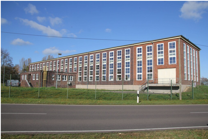
Wasserwerk des Hydrierwerks Zeitz - Gesamtansicht straßenseitig Fotograf/Urheber: NAME FEHLT
