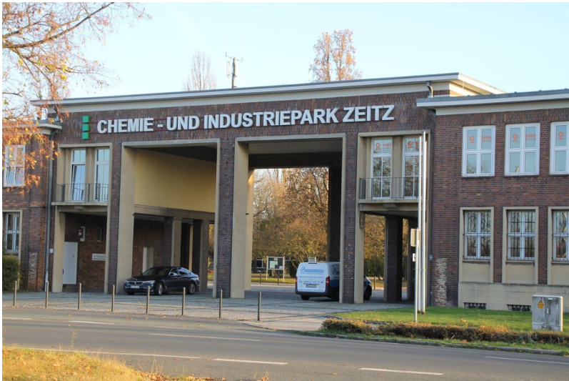
Hydrierwerk Zeitz - Eingangsbereich Fotograf/Urheber: NAME FEHLT
