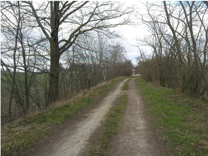
Kohlebahn von Grube 526 Hammerschacht zur Grube Kieferschacht - auf dem Bahndamm; Blick E Fotograf/Urheber: NAME FEHLT
