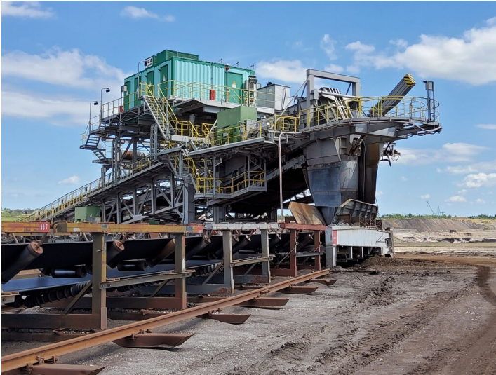
Standort Absetzer 1112 und Antriebsstation A602 am 12.5.2022 - Antriebsstation A602 Fotograf/Urheber: NAME FEHLT
